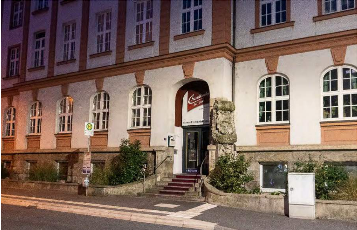
Abbildung 2 Der Haupteingang des Theaters befindet sich in der Mitte des Gebäudes
