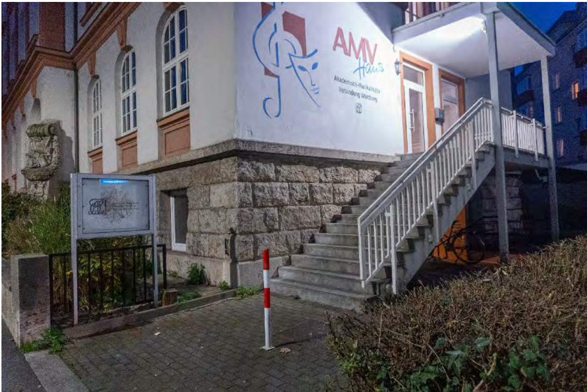
Abbildung 8 Der Seiteneingang befindet sich rechts am Gebäude hinter/unter der Treppe.
